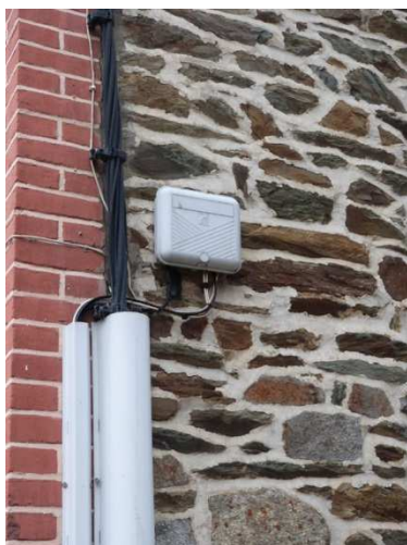
Enfouissement de réseaux
